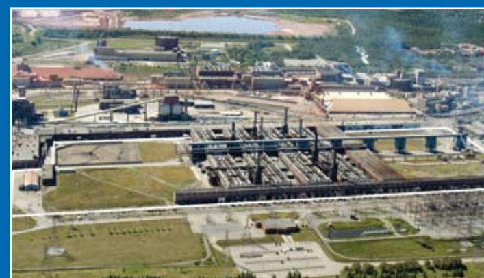
SITE DES ANCIENNES SALLES DE CUVES SÖDERBERG DE L'USINE ARVIDA OÙ SERA ÉRIGÉE L'USINE PILOTE AP50.
