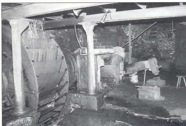
Atelier du Foutlier, roue à aube et marteau. © musée de la Faux.
